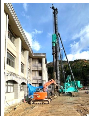
竹野中学校では大きな工事が始まっています。
